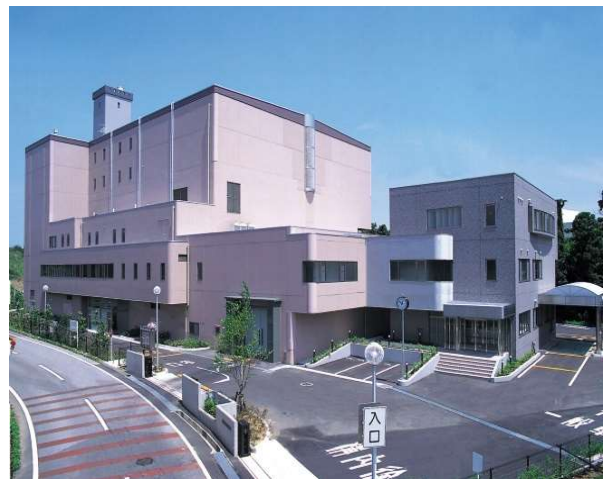
クリーンセンターしらさぎ 外観
