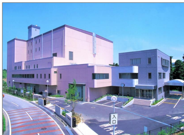
図2-2-3 クリーンセンターしらさぎ全景
