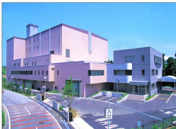
図2-2-3 クリーンセンターしらさぎ全景
